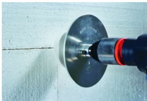
Plug indraaien met hulpstuk
